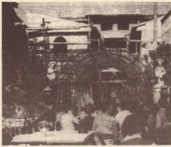
La villa dove è stato scoperto il laboratorio per la trasformazione della morfina base in eroina
